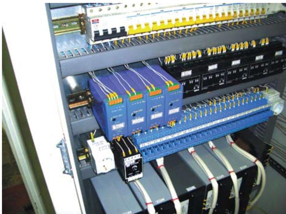
Рис. 3. Пример использования DRAN30 в шкафу промышленной автоматизации
